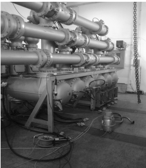
Slika 2. Izgled i raspored elemenata po polju u okviru jednog 110 kV SF6 postrojenja
